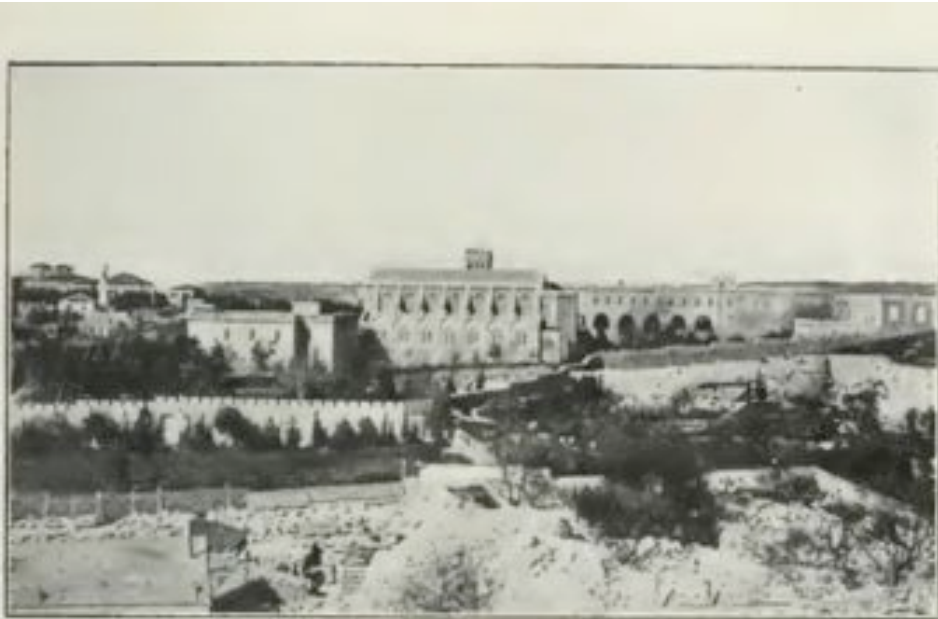
École biblique et sanctuaire de Saint-Etienne, vue du sud.
