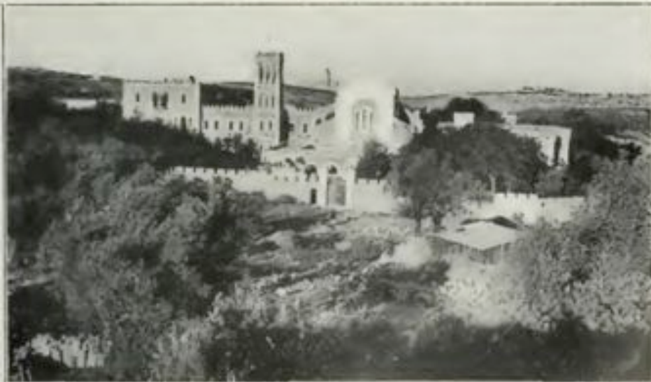
École biblique et sanctuaire de Saint-Etienne, vue de l'ouest.
